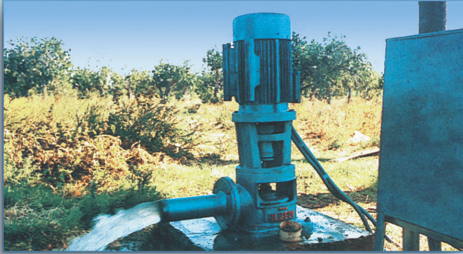
ELEKTRİK MOTORU DİK AKUPLAJ BAĞLANTILI TİP ELECTRIC MOTOR DIRECT COUPLED TYPE
